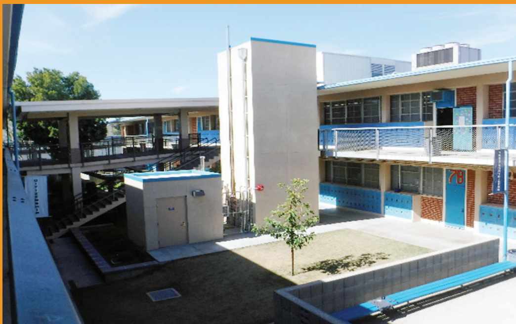
Instalación de ascensor que proporciona acceso a 22 aulas en el segundo piso de dos edificios de aulas de dos plantas.
