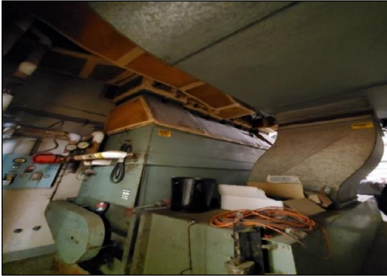
Heat/Vent Unit in Fan Room
